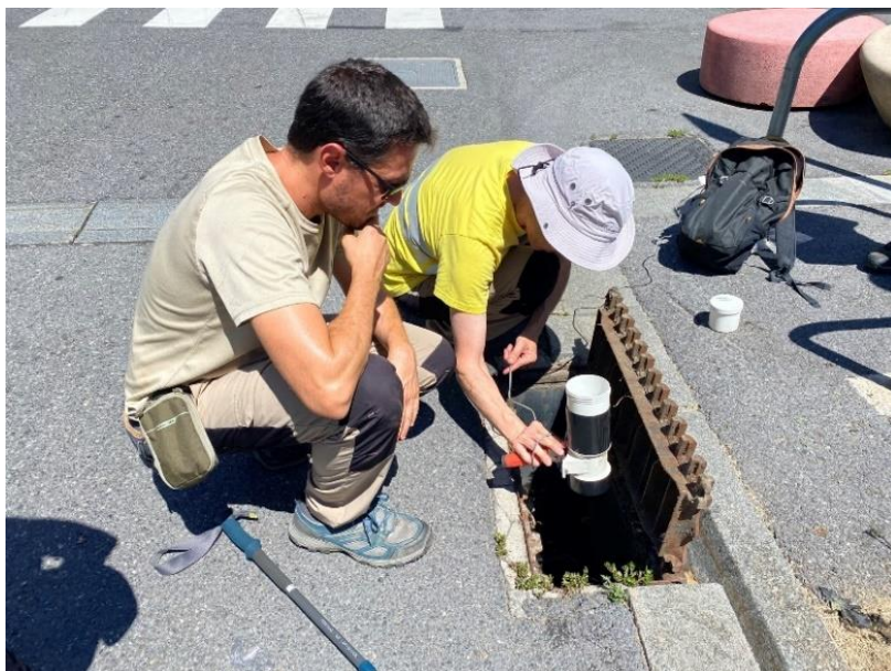
Fotografia 3: Personal del Consell Comarcal del Baix Llobregat aspirant un embornal.
